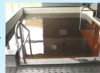
洗浄後の汚れ
